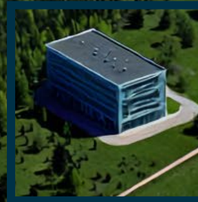
Studsvik Data Center
